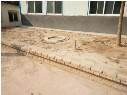
地下式事故池、初期雨水池
