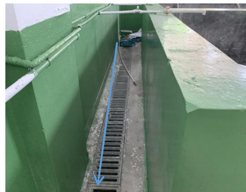
厂区废水收集渠
