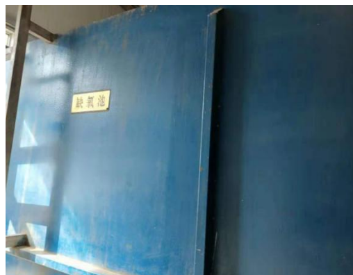
污水处理站缺氧池
