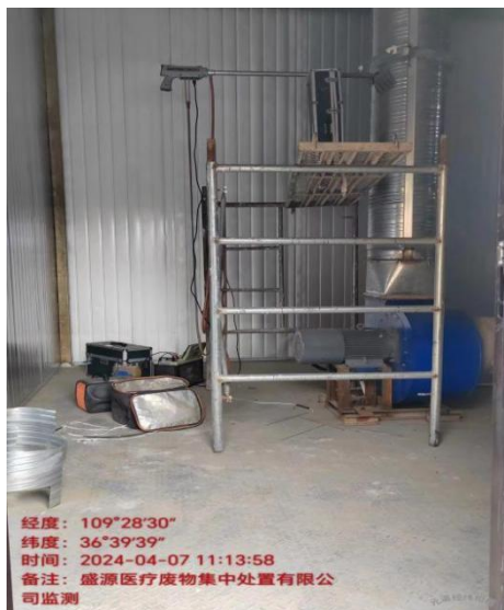
有组织废气采样口
