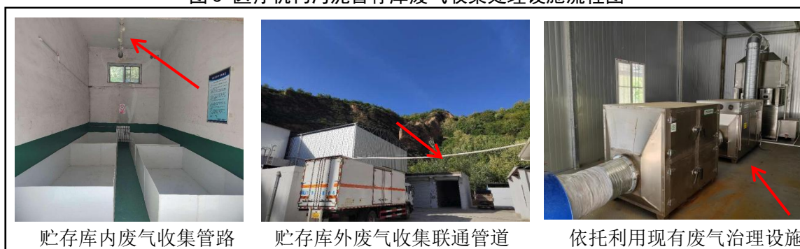
图 5 医疗机构污泥暂存库废气收集处理设施流程图
