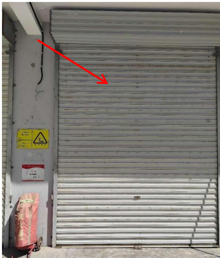
医疗机构污泥贮存库
