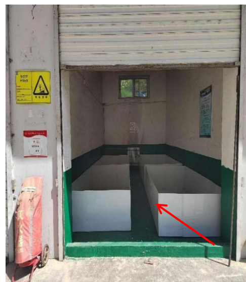
危废间地面墙面防渗且地面铺设 PE 垫板托盘
