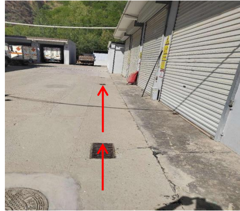
贮存库外截排水渠
